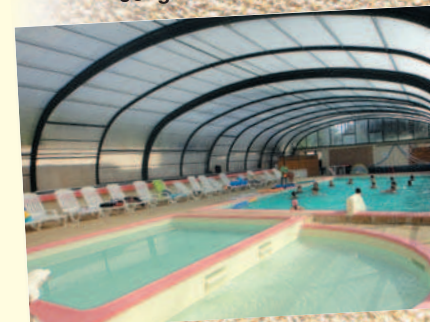
Piscine chauffée couverte
